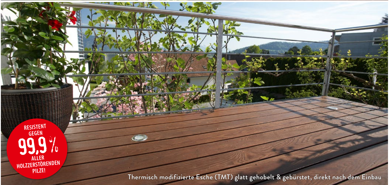
Thermisch modifizierte Esche (TMT) glatt gehobelt & gebürstet, direkt nach dem Einbau
