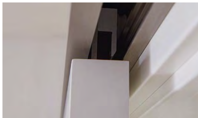
Befestigung einer Holztür im Schiebetürbeschlag SLIM
