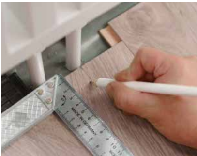
Türzarge und Heizungsrohre
