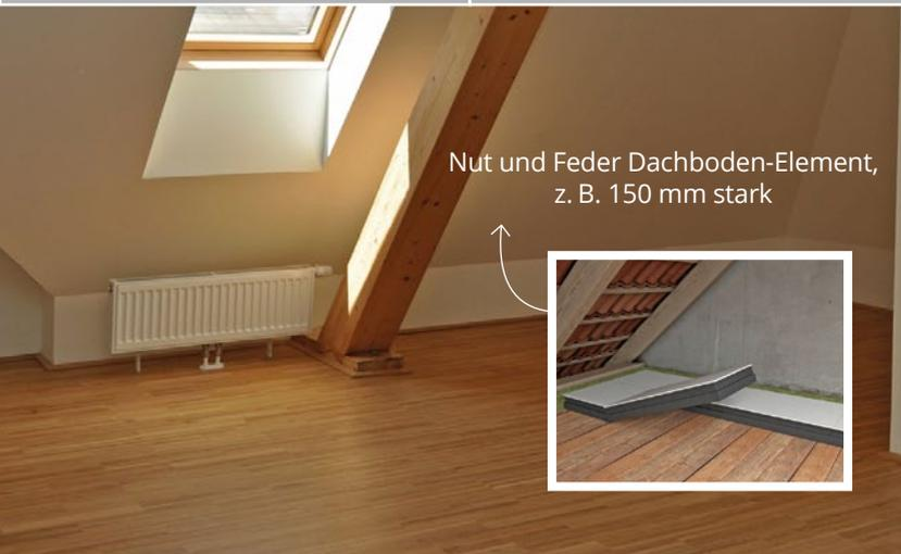
Nut und Feder Dachboden-Element,
