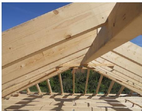
KVH kommt zum Einsatz, wenn das Holz trocken und dimensionsstabil sein soll. Der Zuschnitt aus langen Längen ist verschchnittgünstig. Kleine Längsrisse können vorkommen.
